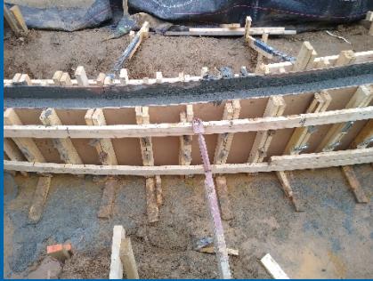
Form and Pour Retaining Wall at ADA Ramp
